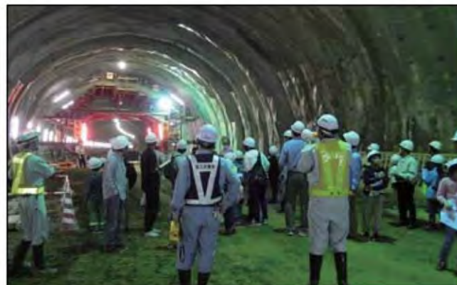
トンネル坑内見学(防水シート台車を稼働)
