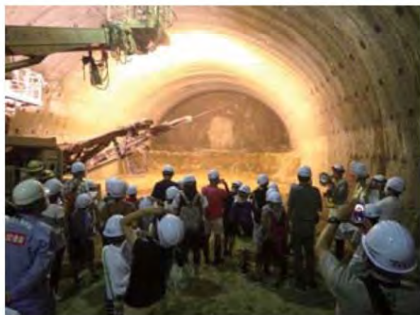
削孔機械を稼働し、説明
